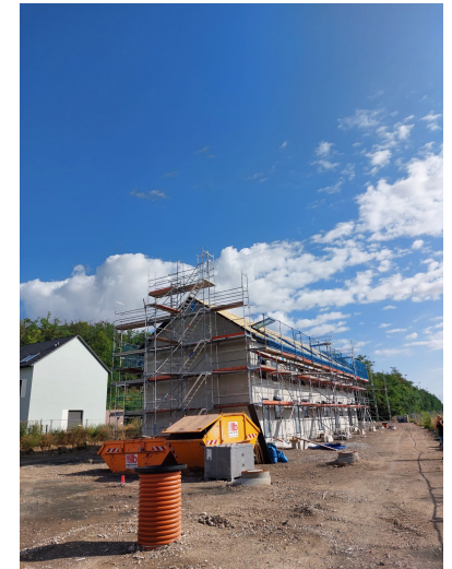
Entstehung eines Reihenhaus
